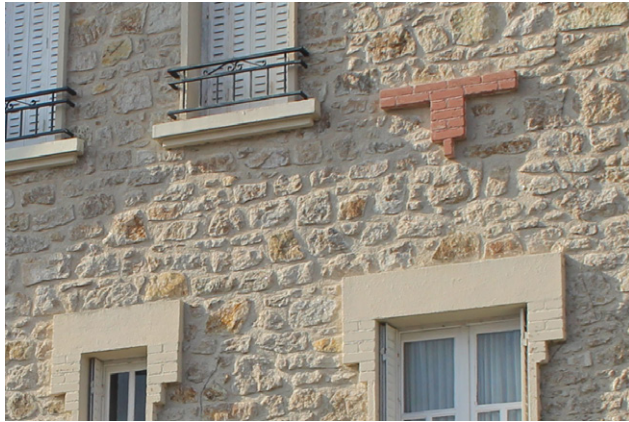
Exemple de parement destiné à être enduit. Les encadrements de baies, en saillie, et le rez-de-chaussée, appareillé en opus incertum sont prévus pour rester apparents.
