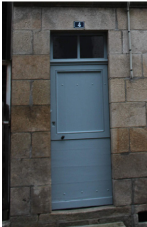
Exemples de portes pleines à panneaux de bois. Ces portes peuvent comporter une partie haute vitrée ou une imposte. Ce type de porte est courant sur les bâtiments à partir du 18 ème siècle.
