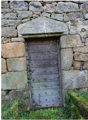
Exemples de portes pleines à lames de bois, elles sont composées d'un parement extérieur à lames verticales et un parement intérieur à lames horizontales. Ce type de porte est courant sur les bâtiments médiévaux.
