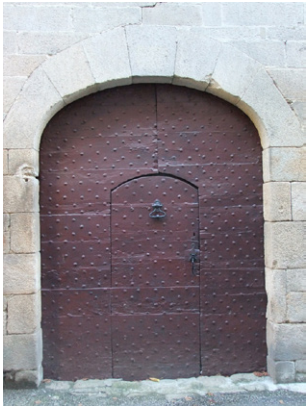
Exemples de portes pleines à lames de bois, elles sont composées d'un parement extérieur à lames verticales et un parement intérieur à lames horizontales. Ce type de porte est courant sur les bâtiments médiévaux.
