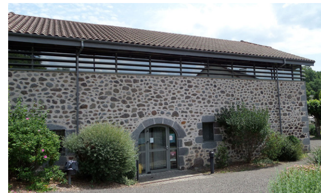
Fenêtre filante (Médiathèque de Jussac, 15)
