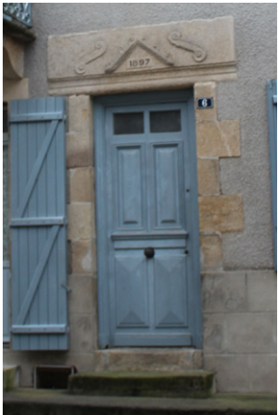
Exemples de portes pleines à panneaux de bois. Ces portes peuvent comporter une partie haute vitrée ou une imposte. Ce type de porte est courant sur les bâtiments à partir du 18 ème siècle.
